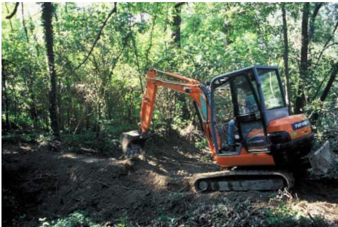
Escavazione di pozza per anfibi (foto Fabio Casale)
