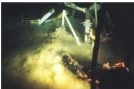
Figura C 4-2 Lancia idraulica in uno scavo sottomarino.
